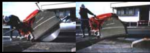
道路カッター
